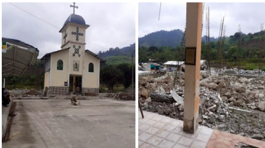
1.8 Destrucción después del aluvión
