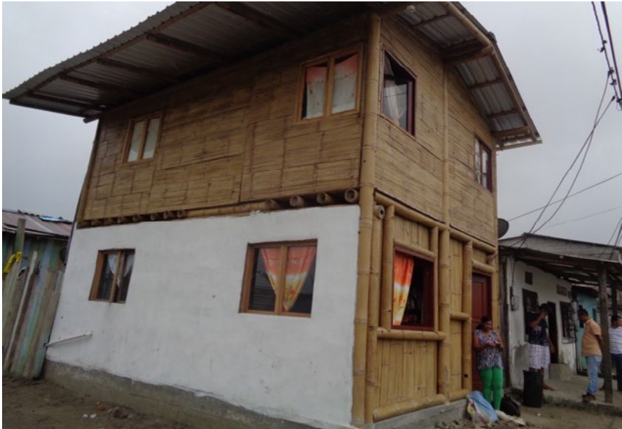
4.8 Casa reconstruida con apoyo solidario . Muisne 2017
