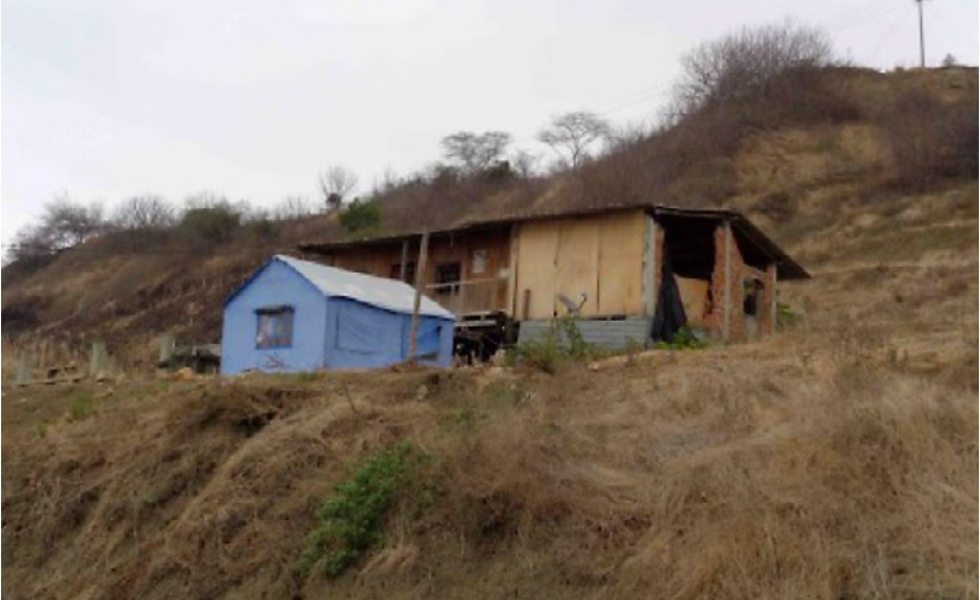
4.2 Asentamiento junto a casa destruída al borde de la carretera
