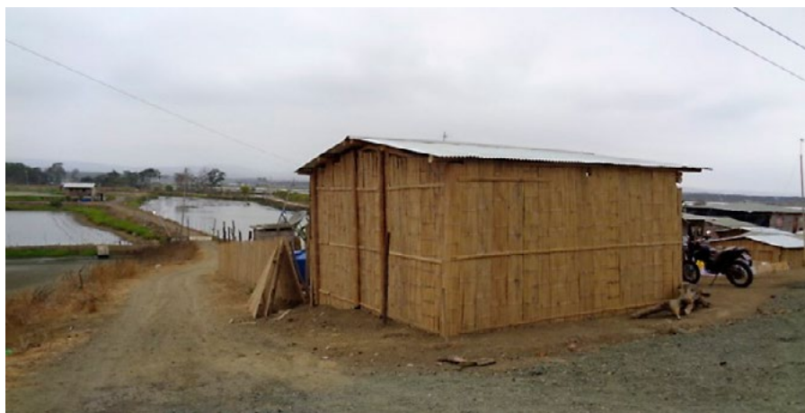
4.3 Casa donadas por USAID frente a piscinas camaroneras
