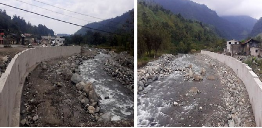
1.10 Muro construido en el río Foto: Rosa Pacari
