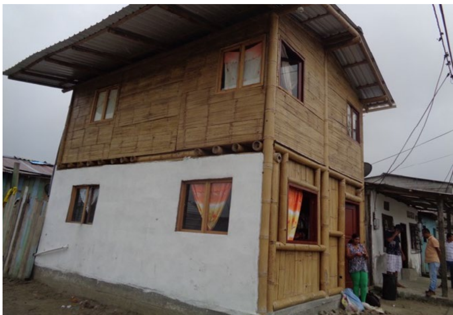
4.8 Casa reconstruida con apoyo solidario . Muisne 2017
