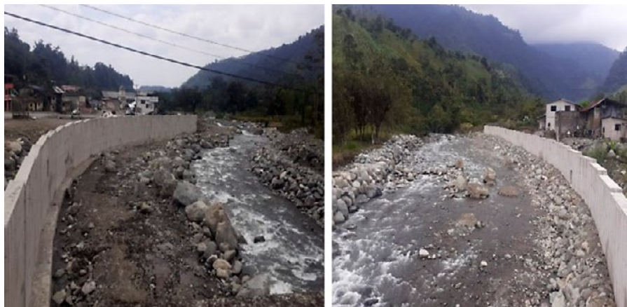
1.10 Muro construido en el río
