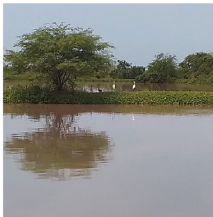
Piscina de oxidación – Comuna ancestral Valdivia
