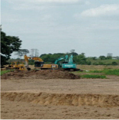
Maquinarias que están realizando trabajos
